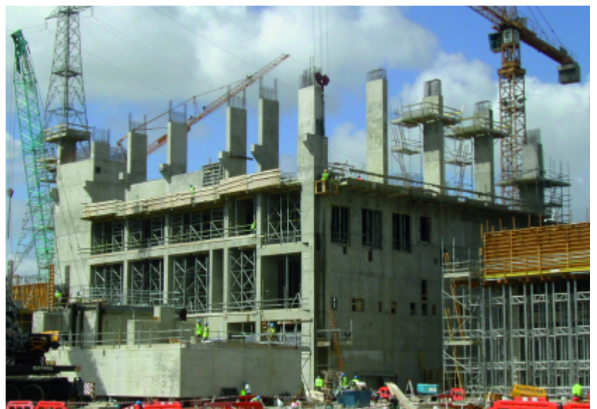
Abb. 6: Schaltwartengebäude im Bauzustand, KW Coolkeeragh in Londonderry/Nordirland
