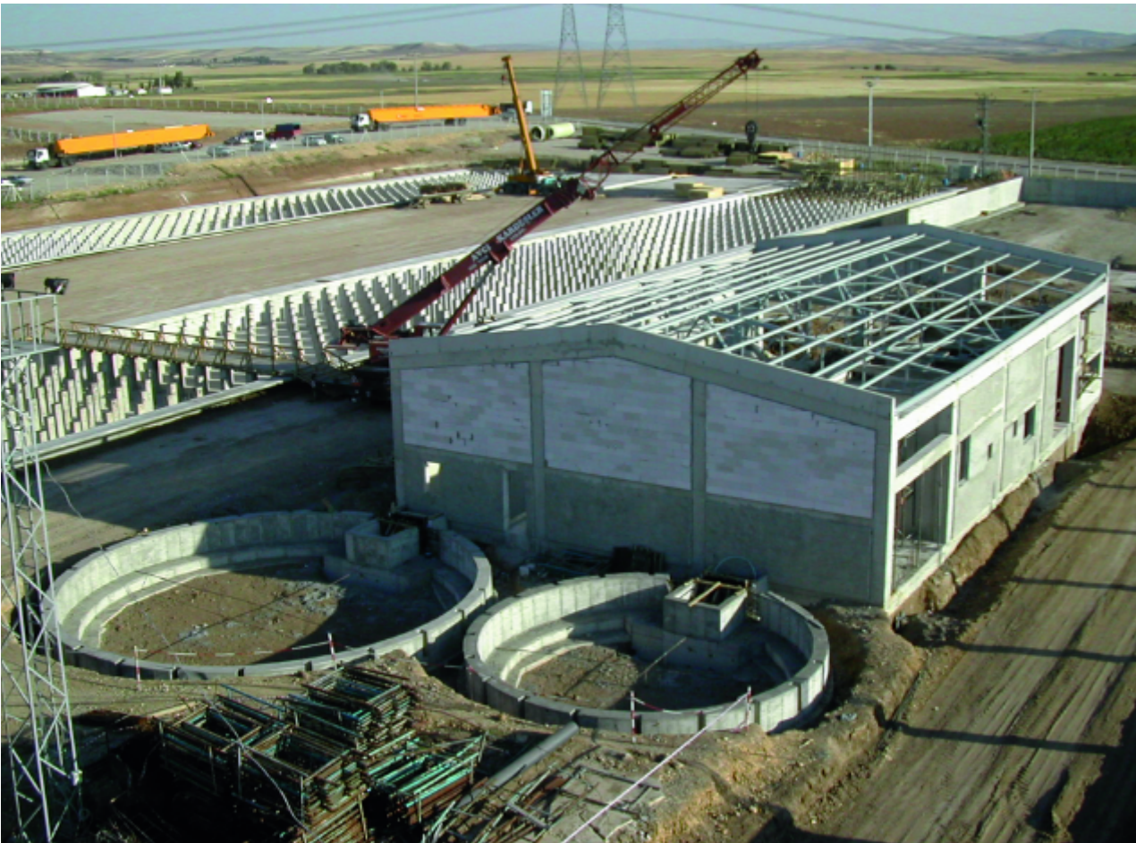
Abb. 11: Wasseraufbereitungsgebäude, Tankfundamente und Becken der Kühltürme, KW Ankara/Türkei
