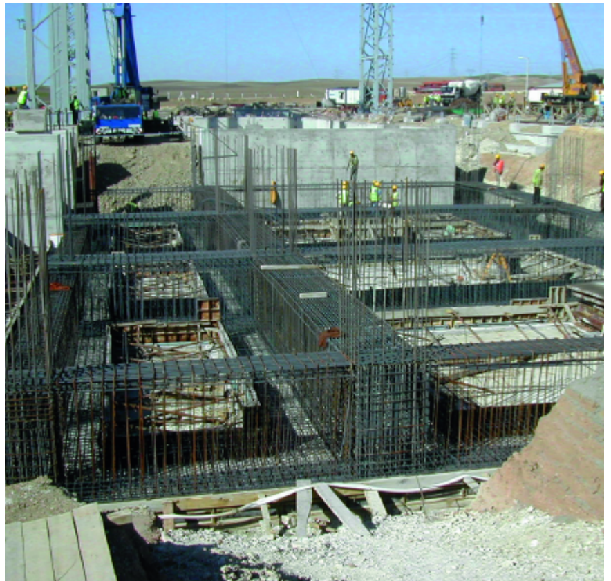
Abb. 8: Fundierung des Abhitzekessels, KW Ankara/Türkei
