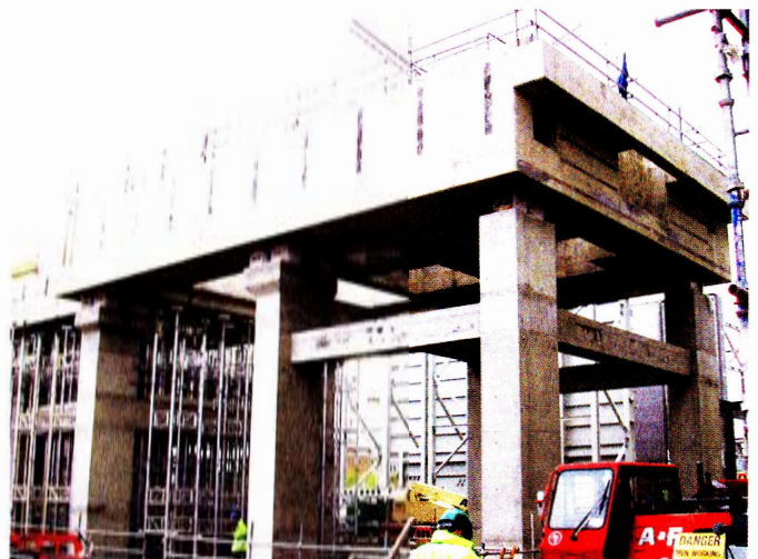
Bild 12. Ansicht des Dampfturbinentisches Fig. 12. View of a steam turbine foundation
